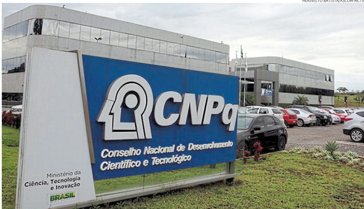
Manutenção. Funcionário do CNPq relatou que o principal servidor do órgão estaria fora da garantia e sem contrato de manutenção
